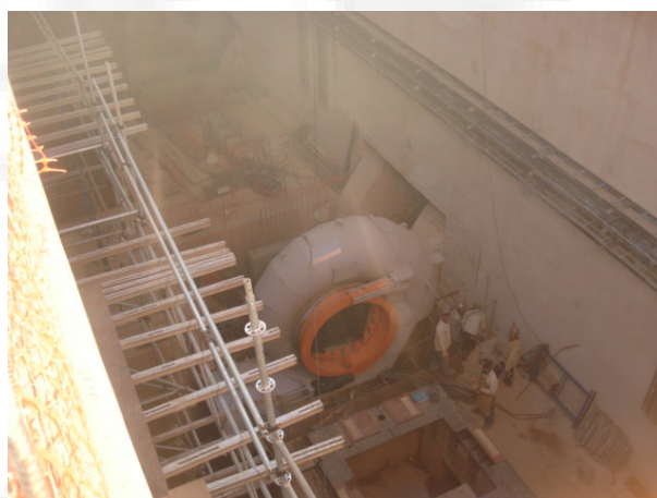
Foto 04. Instalação dos equipamentos na casa de força da PCH Pipoca.
