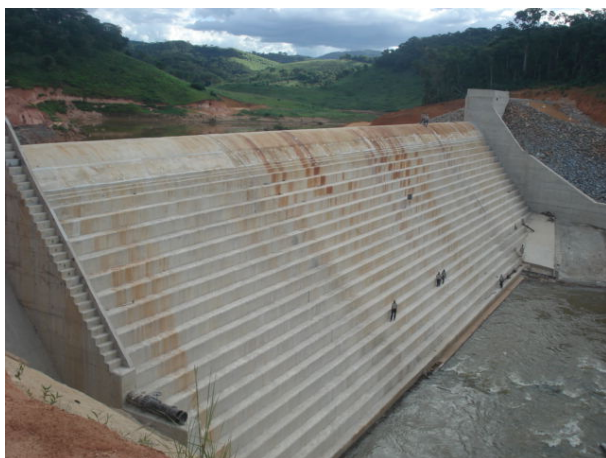
Foto 01. Barramento PCH Pipoca.
