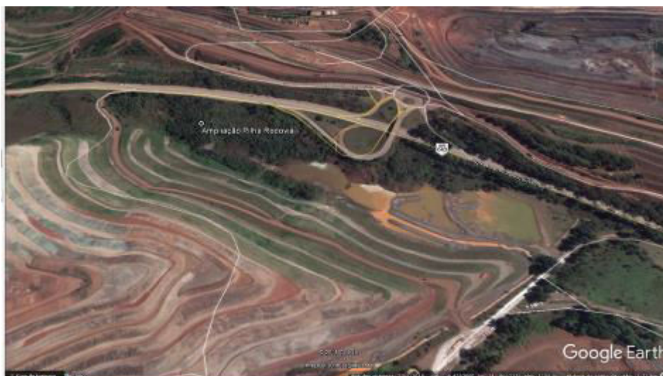
: Pilha da Rodovia atual e a área onde ocorrerá a ampliação.
