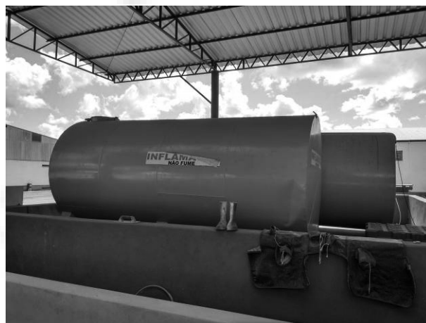
Foto 02. Posto de abastecimento
