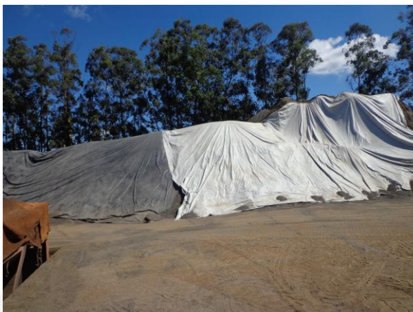
Figura 02 - Agregados cobertos por lonas
