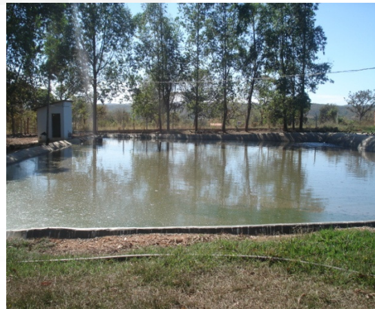
Foto 2: Lagoa de estabilização
