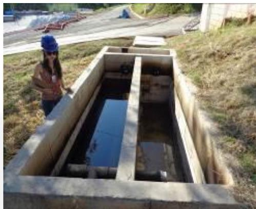
Figura 7: Caixa Separadora de Água e Óleo
