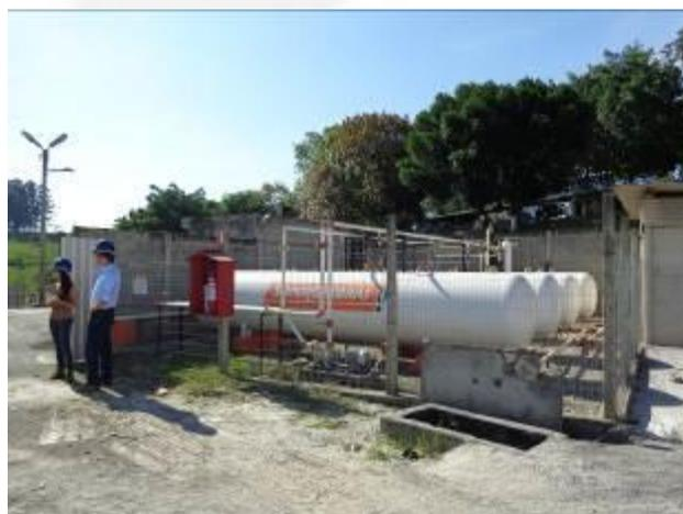
Figura 2: Base de armazenamento GLP
