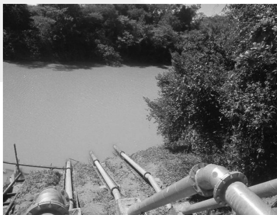
Foto 04. Captação no Rio Preto
