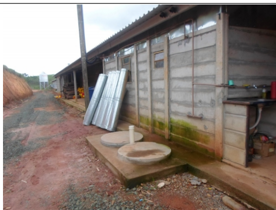
4 - Fossa séptica instalada junto a cada galpão.
