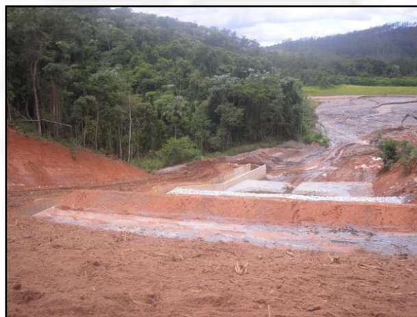
Foto 04: Vista ampla do final do dreno de fundo.
