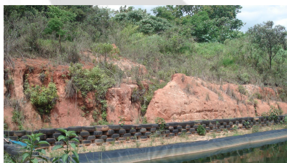
Talude lateral à lagoa facultativa
