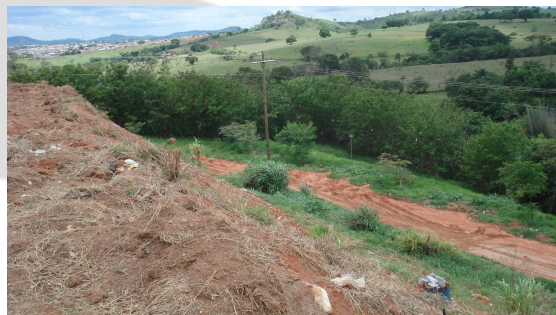
Talude lateral da plataforma em uso
