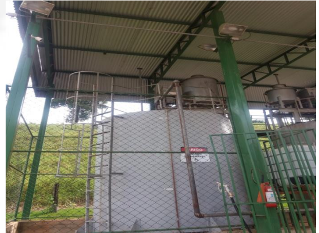
Foto 4. Ponto de Abastecimento de veículos
