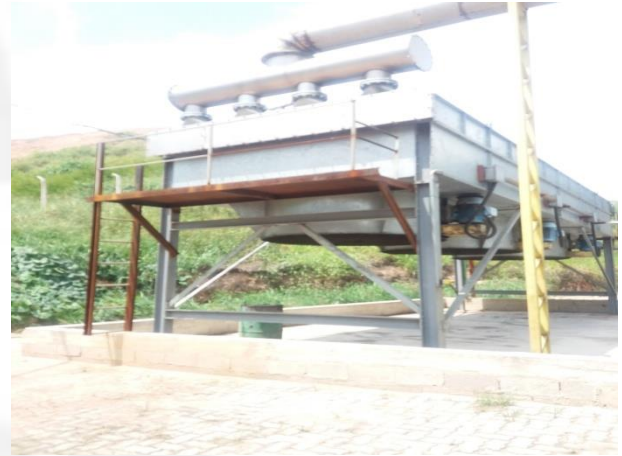
Foto 2. Aero condensador
