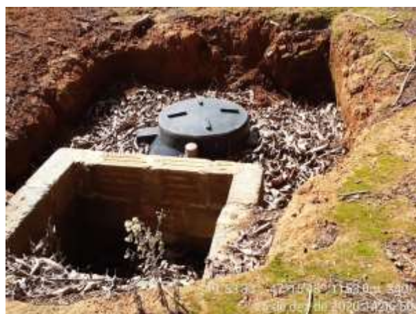
Figura 10. Fossa séptica seguida de sumidouro
