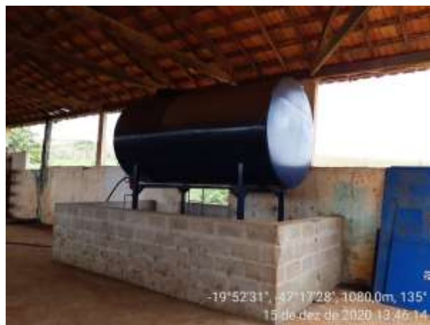
Figura 14. Tanque de combustível desativado
