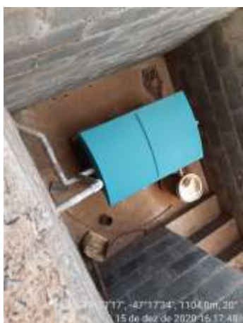
Figura 9. Caixa Separadora de Água e Óleo - CSAO
