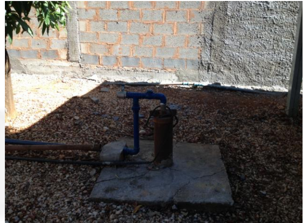
Foto 06. Poço tubular
