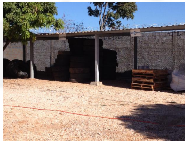
Foto 04. Depósito temporário de descarte
