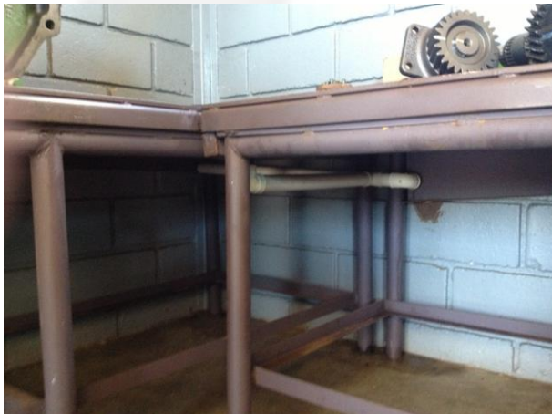
Foto 07. Bancada para reparos na área Motor e Transmissão
