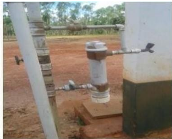
Figura 05: Caixa d'água com sistema de cloração na PLC
