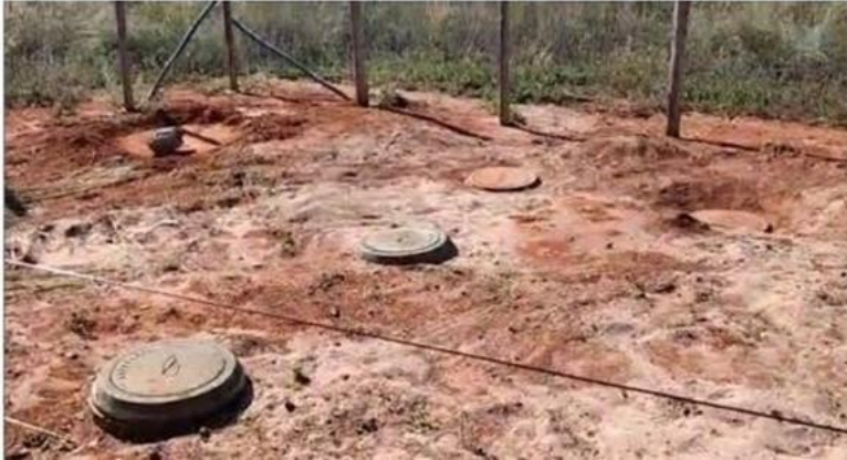
Figura 10: Caixa SAO do pátio de máquinas PLC
