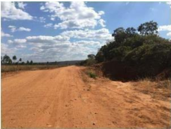
Figura 04: Estradas/aceiros do empreendimento
