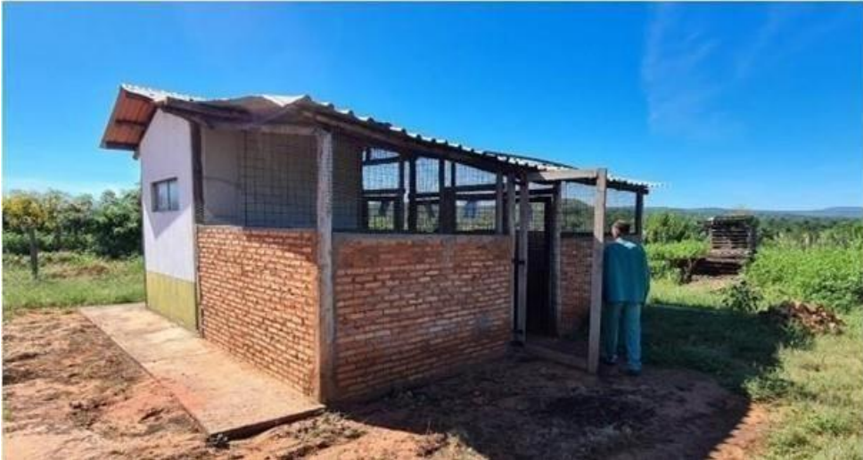
Figura 13: Cômodo utilizado para o armazenamento temporário dos resíduos gerados na Fazenda Fartura
