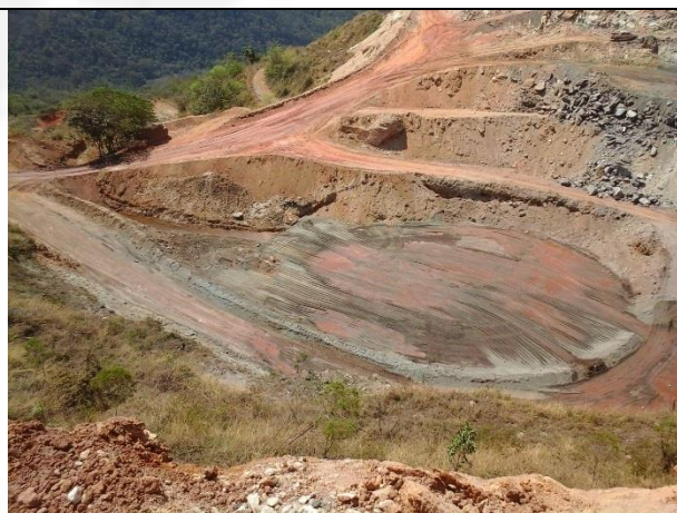
Fotografia 16: Sump da cava central. Vistoria 26/08/2015.
