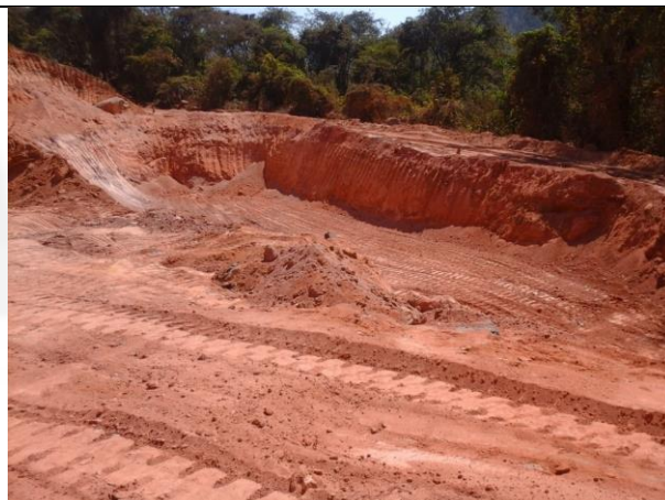
Fotografia 08: Área de empréstimo. Nota-se solo com coloração matiz R de acordo com a carta de Munsel indicando possivelmente maior teor de argila, motivo pelo qual foi utilizado na construção do barramento. Vistoria 26/08/2015.
