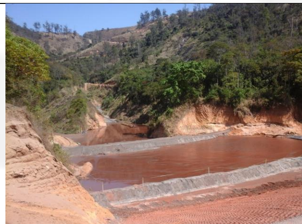
Fotografia 09: Barragem de rejeitos em operação. Observa-se que o ponto inicial do talvegue se encontra revegetado. Vistoria 26/08/2015.
