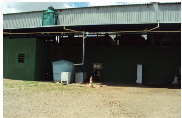
- Captação de água de chuva, e caixa d'água.
