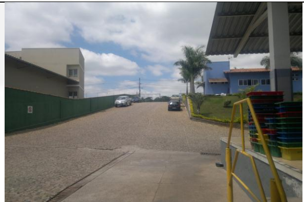
Acesso à empresa, piso concretado e sistema de drenagem.
