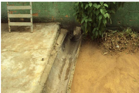
- Sistema de drenagem.
