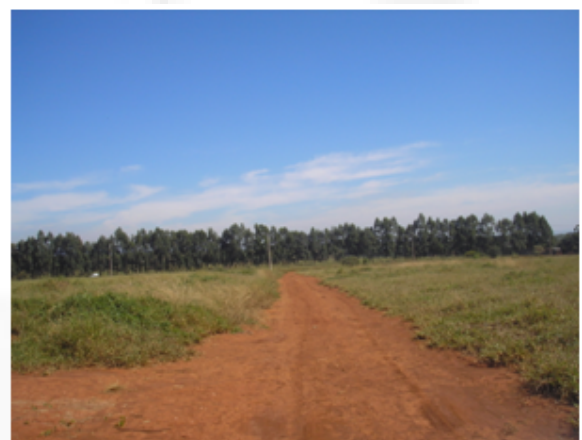
Foto 04. Área do Empreendimento destacando abertura de arruamento.
