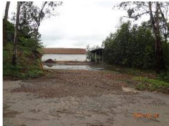
Foto 30: Área de pátio com acúmulo de água de chuva e arraste de sedimento na saída para o acesso.
