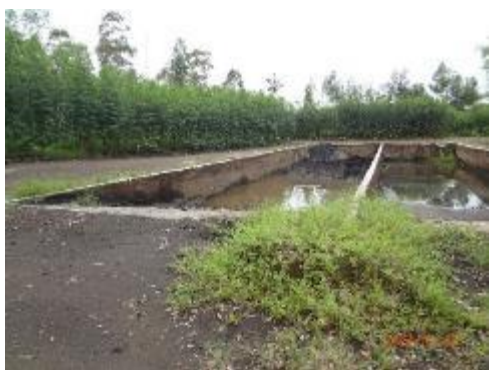
Foto 13: Tanque de decantação de pó de balão
