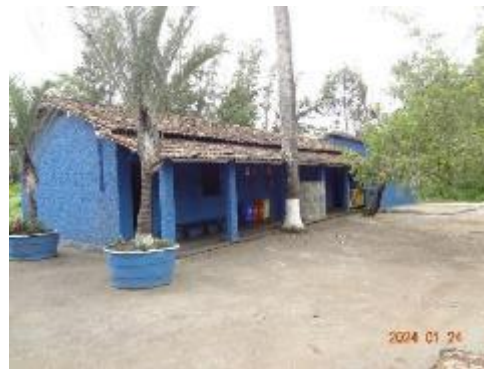
Foto 16: Banheiros e vestiário próximo à área dos altos-fornos.
