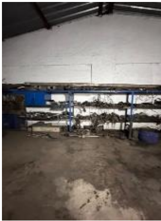
Foto 21: Piso interno da oficina e armazenamento de materiais.
