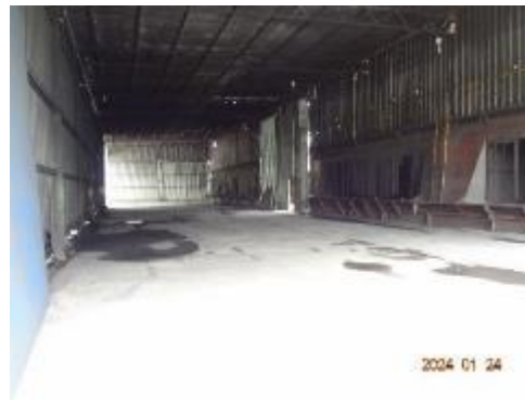
Foto 10: Galpão de descarga de carvão vegetal.
