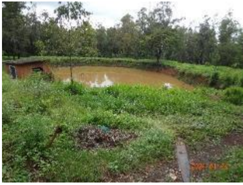
Foto 25: Tanque de sedimentação.
