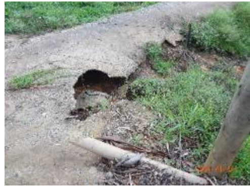
Foto 26: Detalhe do vertedouro do tanque de sedimentação.
