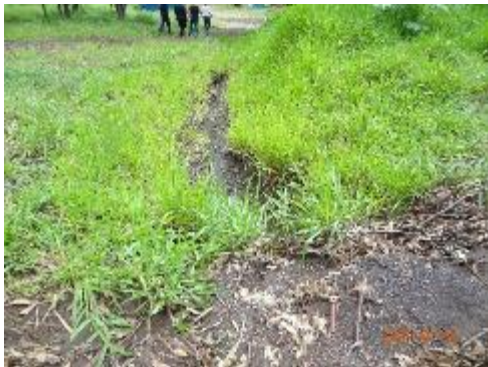
Foto 29: Sulco em meio à vegetação por onde parte da água de chuva escoar em direção ao tanque de sedimentação.
