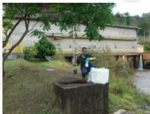
Foto 06: Conjunto fossa/filtro anaeróbico, vala de filtração (tratamento secundário) e poço de amostragem
