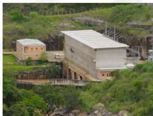
Foto 04: Casa de força
