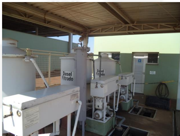
Foto 04. Área de filtros de diesel
