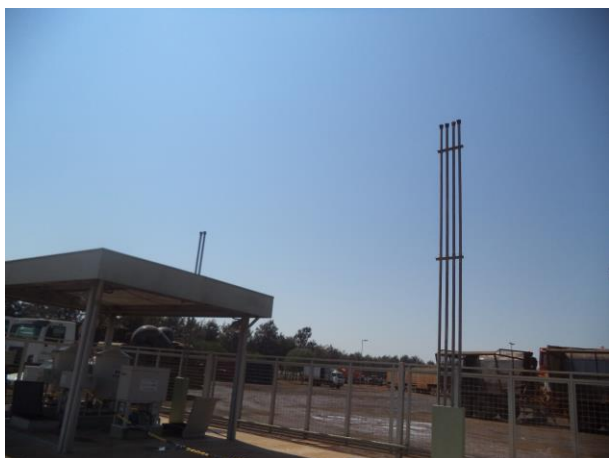
Foto 05. Respirios dos tanques
