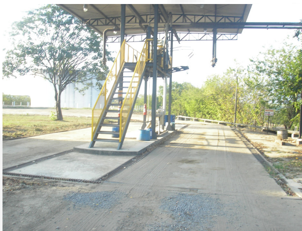
Foto 03. Ponto de abastecimento dos caminhões tanques.
