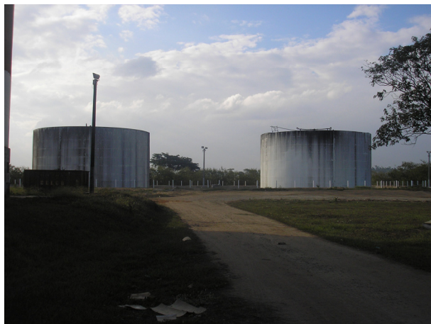
Foto 01. Tanques de Álcool com bacia de contenção.
