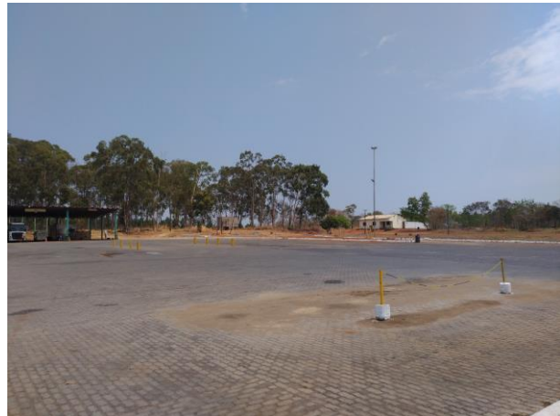
Foto 2: Pátio de Estacionamento
