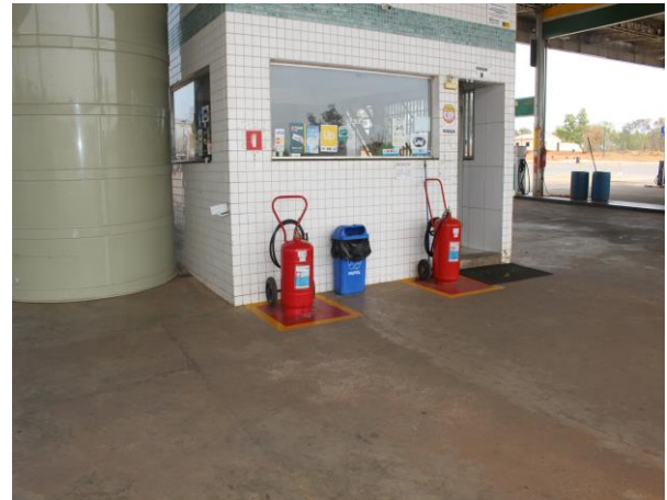
Foto 6: Equipamentos de combate de incêndio
