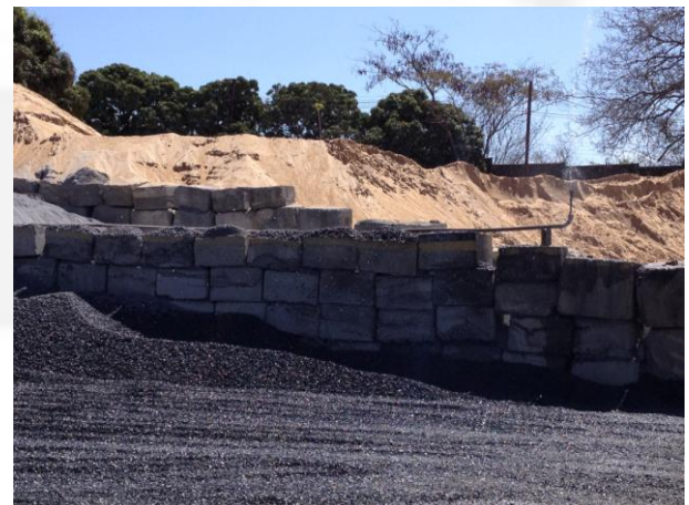
Foto 04. Sistema de aspersão nas baías
