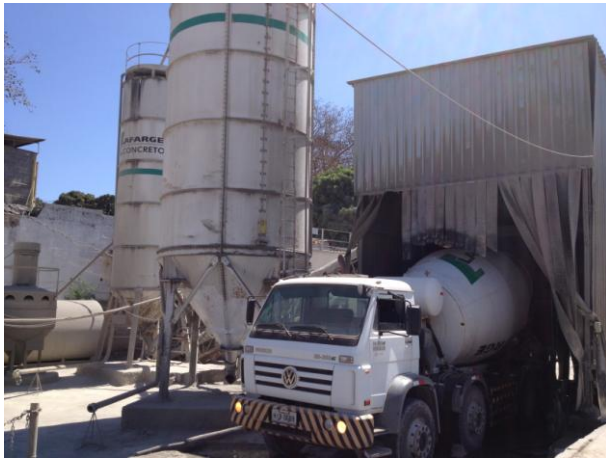
Foto 05. Enclausuramento durante o abastecimento de matérias primas nos caminhões
