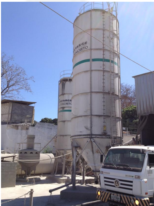
Foto 07. Silo de estocagem de cimento
