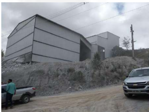
Foto 05. Britagem primária da UTM I enclausurada
