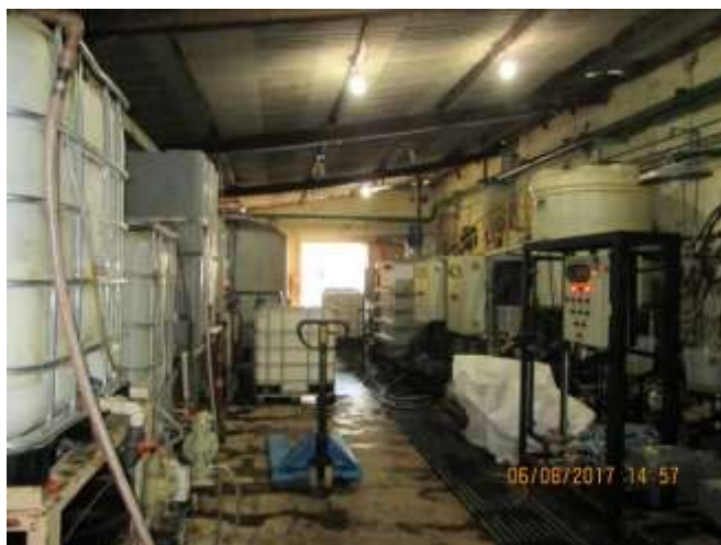
Figura 05: Depósito de produtos químicos.
