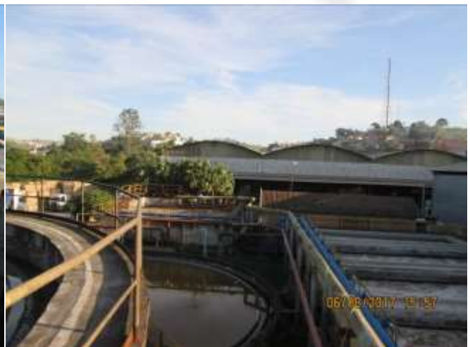
Figura 04: ETE industrial secundária.
