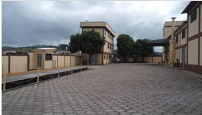
Foto 1: Vista do pátio com a balança e o prédio do refeitório e escritório.
