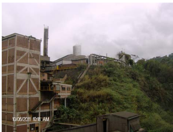
Foto 03. Vista da unidade industrial atual em operação (Plantas PL3 e T560).
