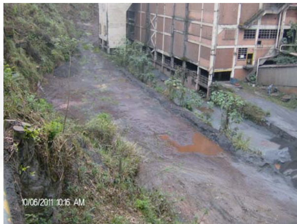
Foto 02. Área de instalação da subestação de energia elétrica.
