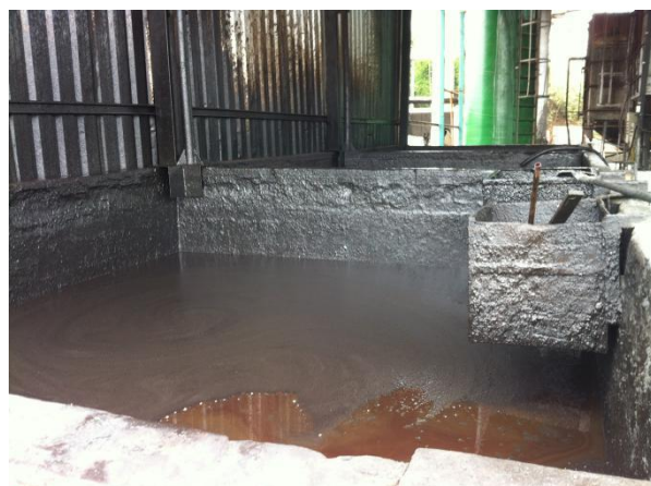
Foto 02. O tanque de armazenamento de óleo apresenta superfícies impermeabilizadas.
