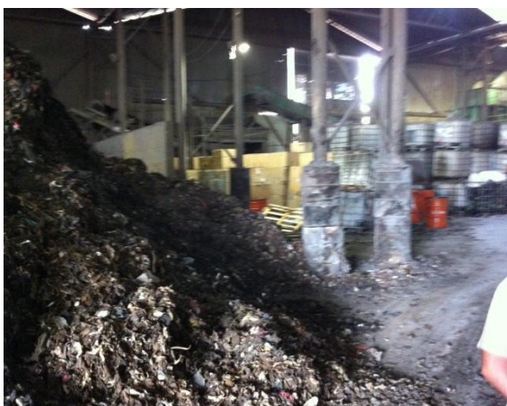
Foto 03. Galpão de blendagem contendo piso impermeável e fechamentos lateral e superior.
