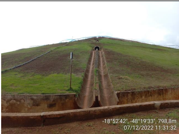
Foto 05 – Talude com grama
