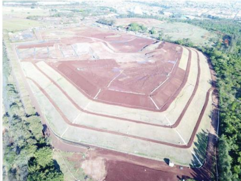
Figura 1- Vista aérea do aterro. (Fonte: RADA- Limpebras, 2019 e relatórios de condicionantes).
