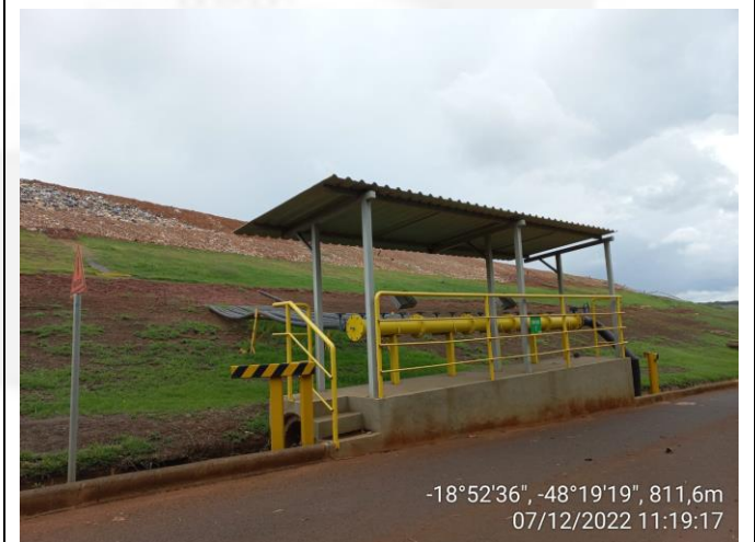
Foto 04 – Sistema de coleta de gás.
