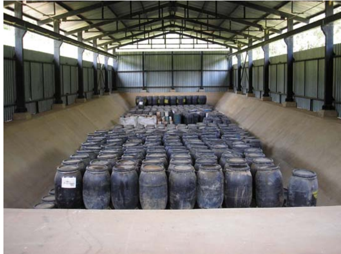
Fotografia 1 – Baía devidamente impermeabilizada, coberta e acondicionamento das bombonas com os resíduos
