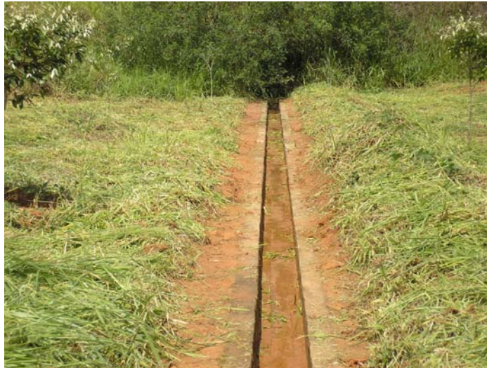
Fotografia 6 – Drenagem pluvial em perfeitas condições
