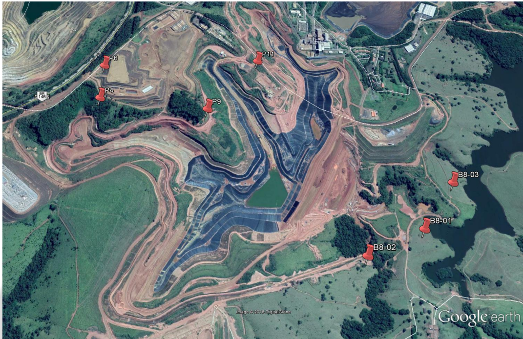
Pontos de monitoramento de águas subterrâneas.
