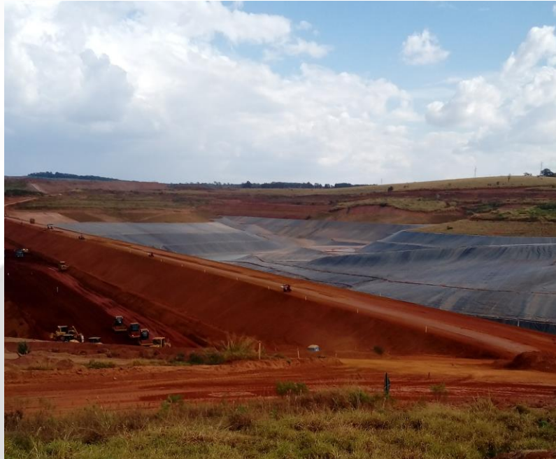
Vista do maciço, ombreiras e interior da barragem revestido em manta PEAD.
