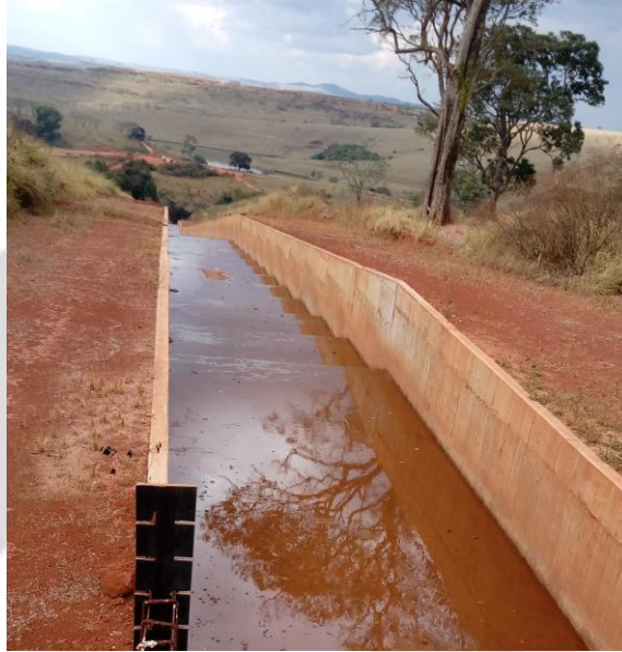
Extravador da barragem de rejeitos.
