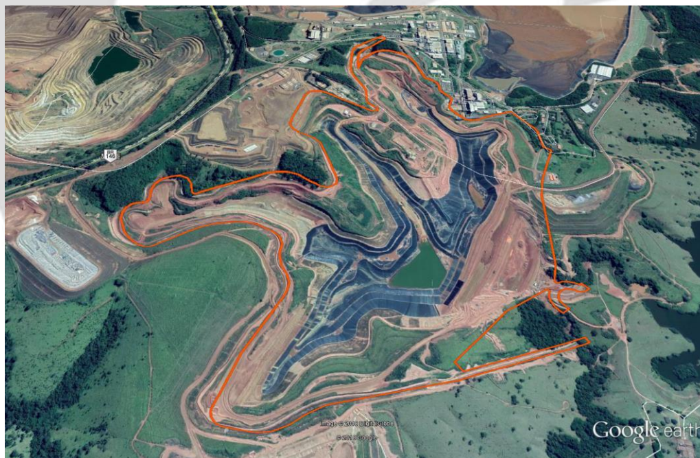
Delimitação da cota máxima de inundação da barragem B8.
