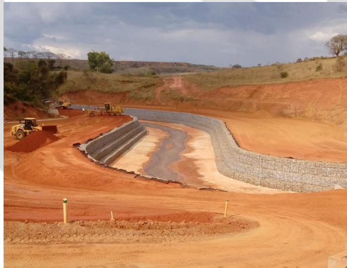
Desvio do curso d'água à jusante do maciço.
