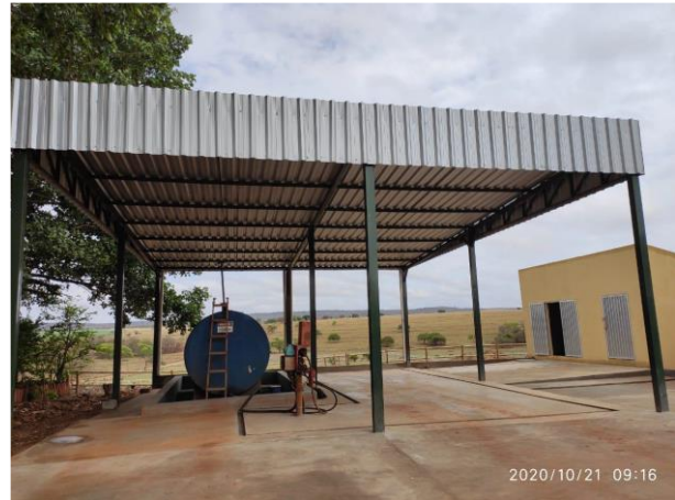
Foto 06. Ponto de abastecimento de combustíveis
