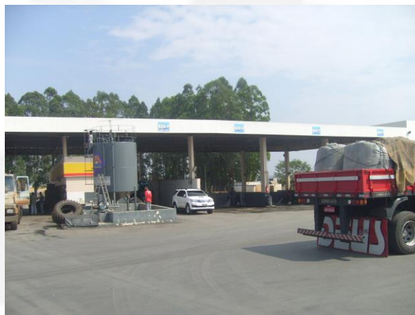
Foto 4: Tanque de armazenamento de óleo.
