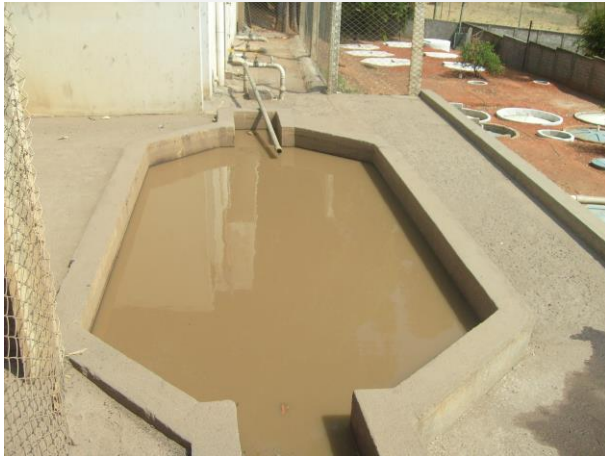
Foto 13: Caixa desarenadora.
