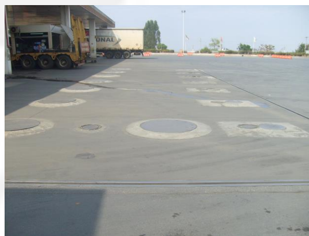
Foto 2: Área de descarga de combustíveis.
