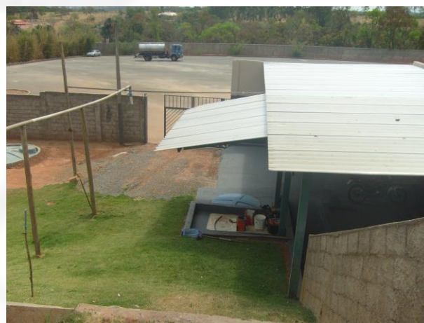
Foto 8: Depósito temporário de resíduos coberto.
