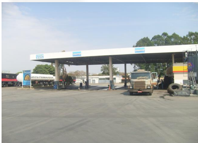
Foto 3: Área de lavagem de veículos grandes.
