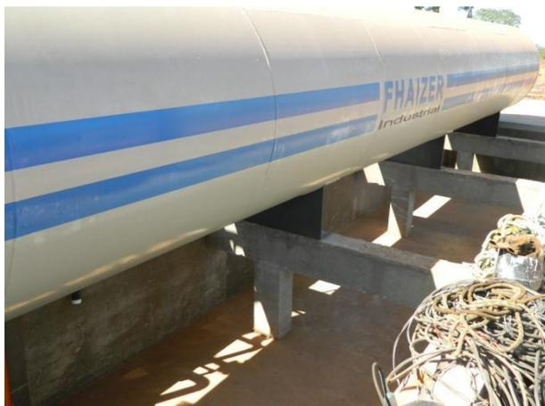
Foto 05. Caixa de contenção de vazamentos.
