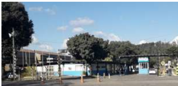
Figura 01. Visão geral do empreendimento.
