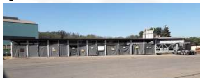
Figura 06. Central de resíduos perigosos.
