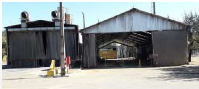
Figura 02. Cabine de Pintura 3 e Cabine de Pintura Móvel.
