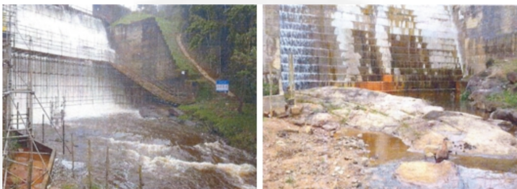
Figura 2 - À esquerda, barramento em obras em dezembro de 2018. À direita, barramento já sem obras em setembro de 2019. Fonte: Siam nº 0771865/19.
