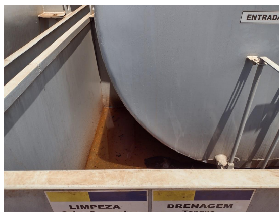
Foto vistoria 02: Tanque com bacia de contenção
