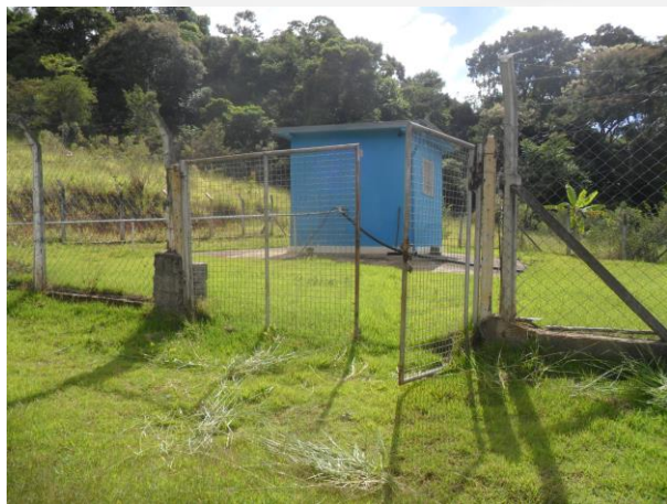
Foto 01. Casa de proteção da fonte
