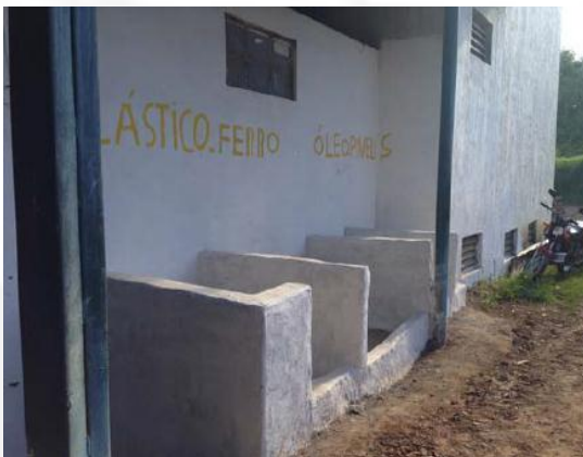
Foto 10: Depósito de resíduos sólidos.
