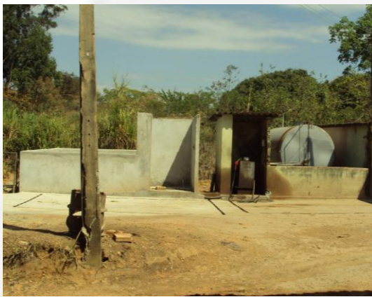
Foto 13: Posto de abastecimento – Tanque 1.
