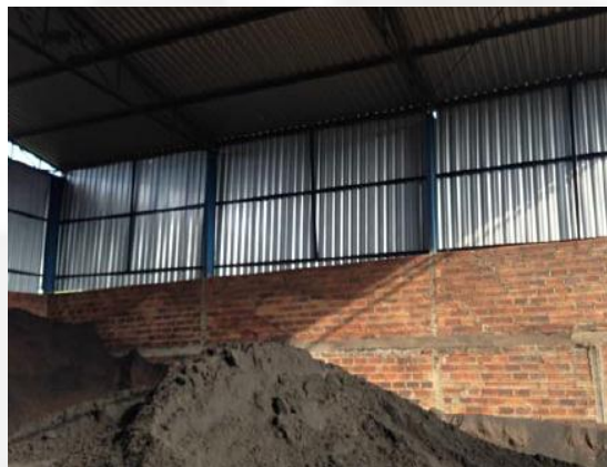
Foto 4: Depósito de pó de balão – vista interna.
