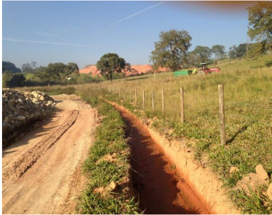
Foto 11: Sistema de drenagem pluvial.
