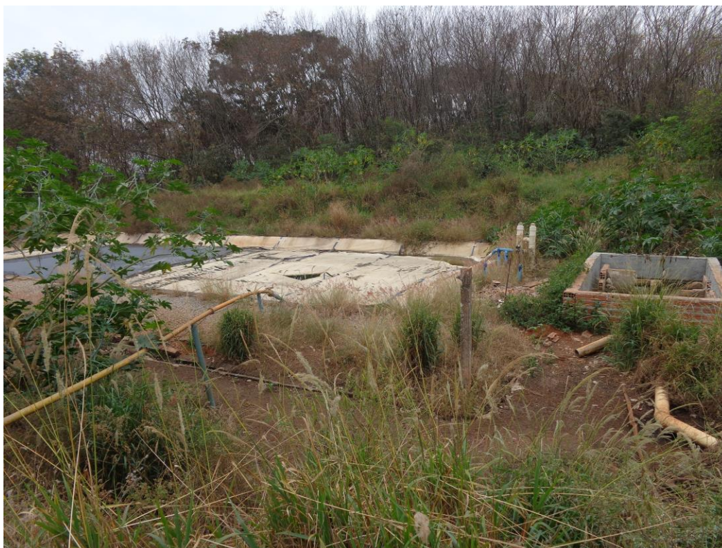
Foto: 09. Biodigestor com lona rasgada sem o devido funcionamento
