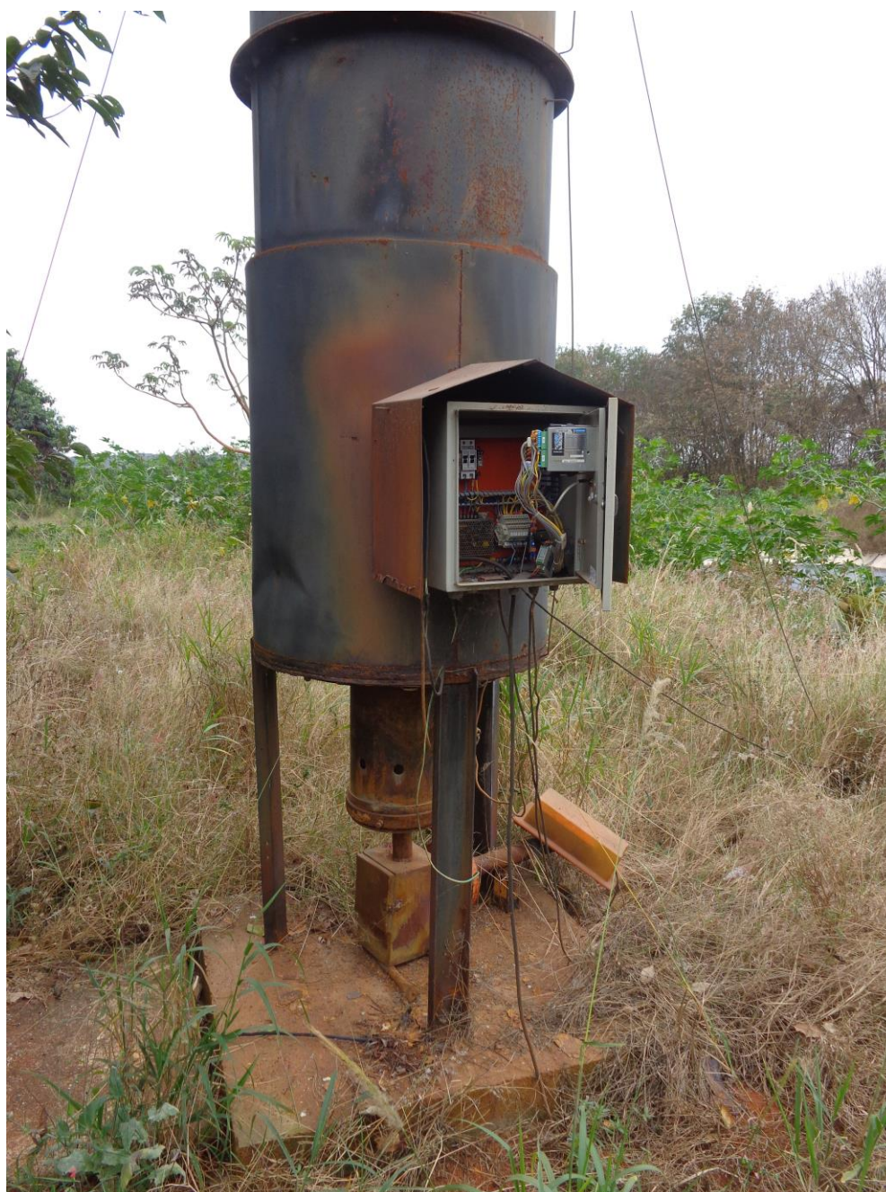
Foto: 10. Queimador de gás metano sem funcionamento
