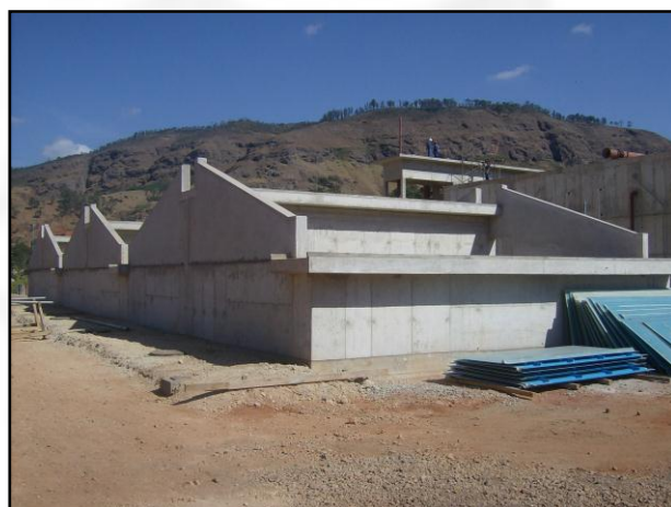
Foto 04: Vista dos leitos de secagem do lodo.
