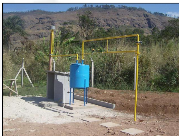
Foto 06: Queimador de Gases
