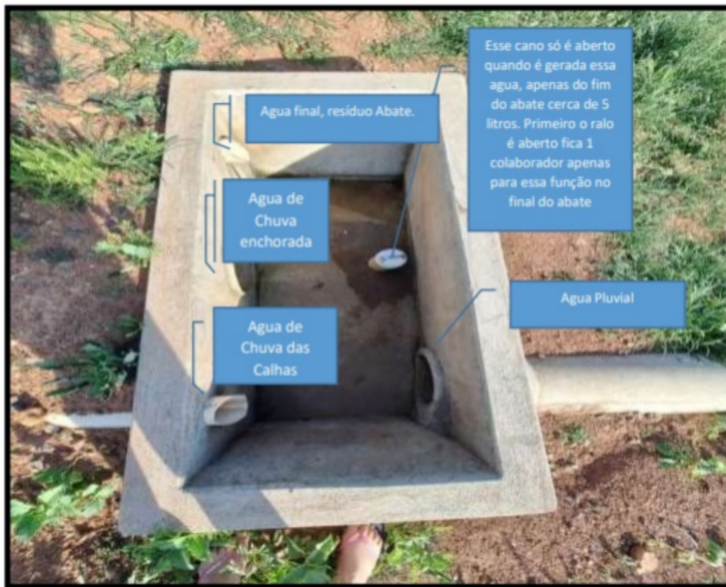
Figura 2. Caixa que recebe o efluente pluvial e de lavagem do setor da recepção das aves. Fonte: IC nº 1, identificador do SLA 143267.
