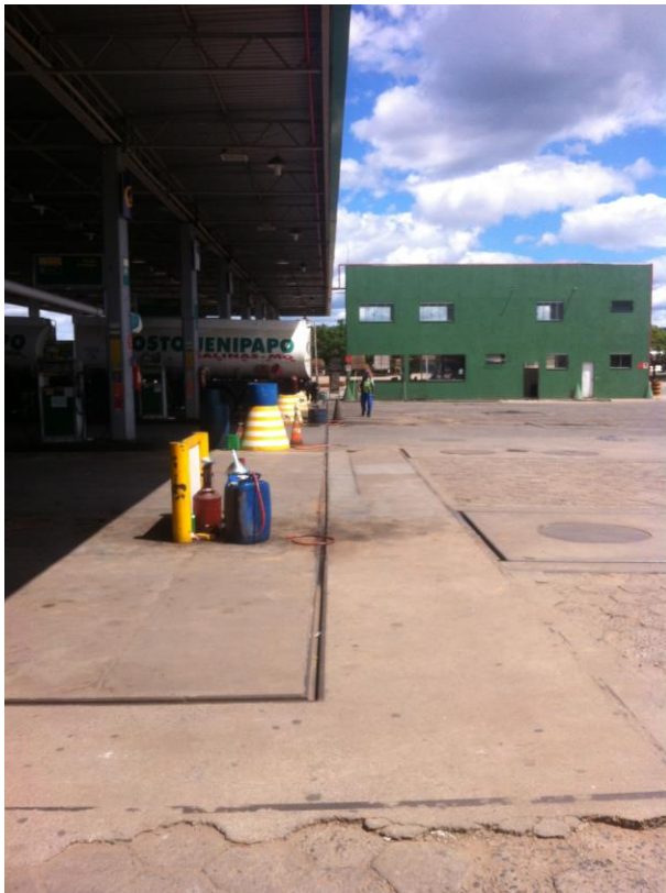
Imagem 07: visão canaletas da pista.
