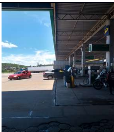
Canaletas sob a projeção da cobertura
