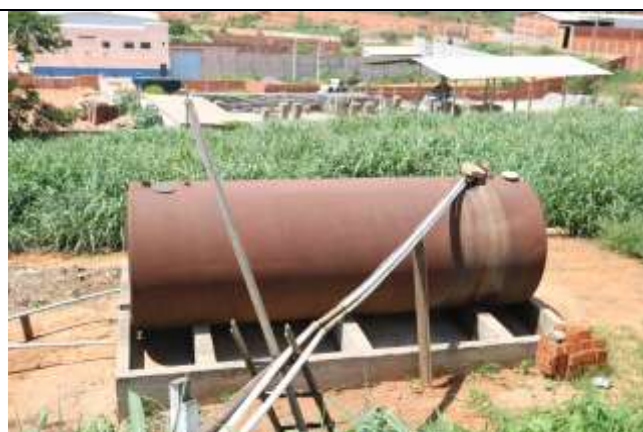
Reservatório de óleo lubrificante usado.
