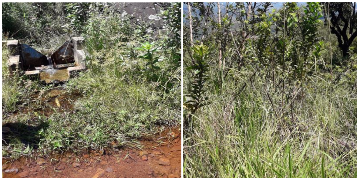
Foto 8.19 e 8.20: local de intervenção em APP de curso d'água. Fonte: Vistoria equipe Suppri Fev/2022.
