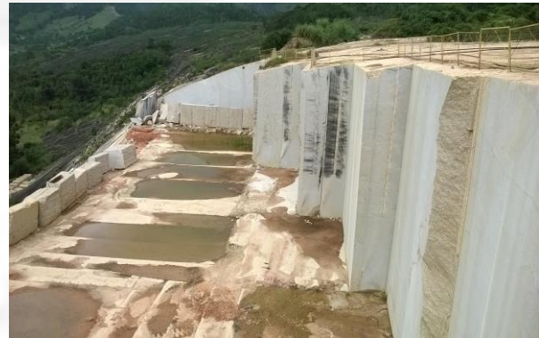
Foto 2. Frente de lavra a ser ampliada.
