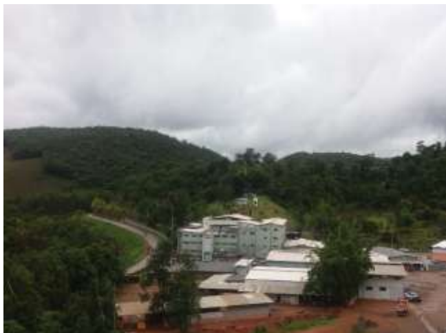
Foto 01: Visão geral do empreendimento.
