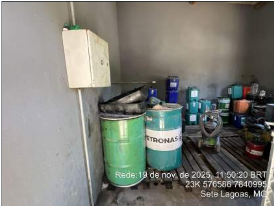
Foto 10: Abrigo de resíduos perigosos.
