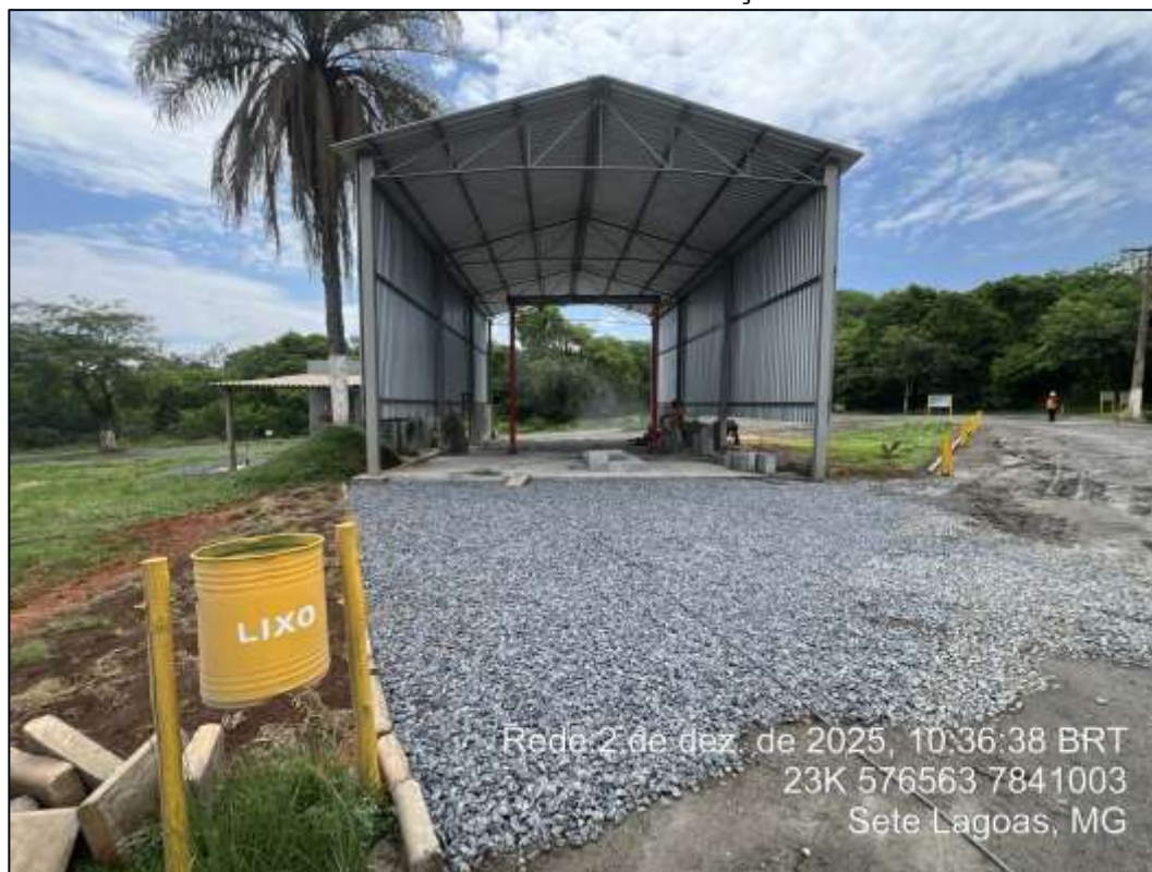
Foto 11: Área de manutenção.
