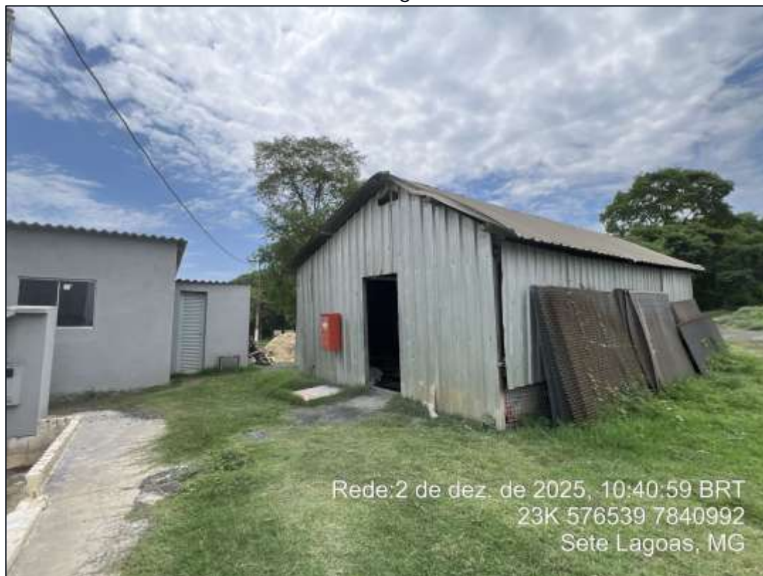
Foto 20: Vista externo do abrigo de materiais e sucatas.
