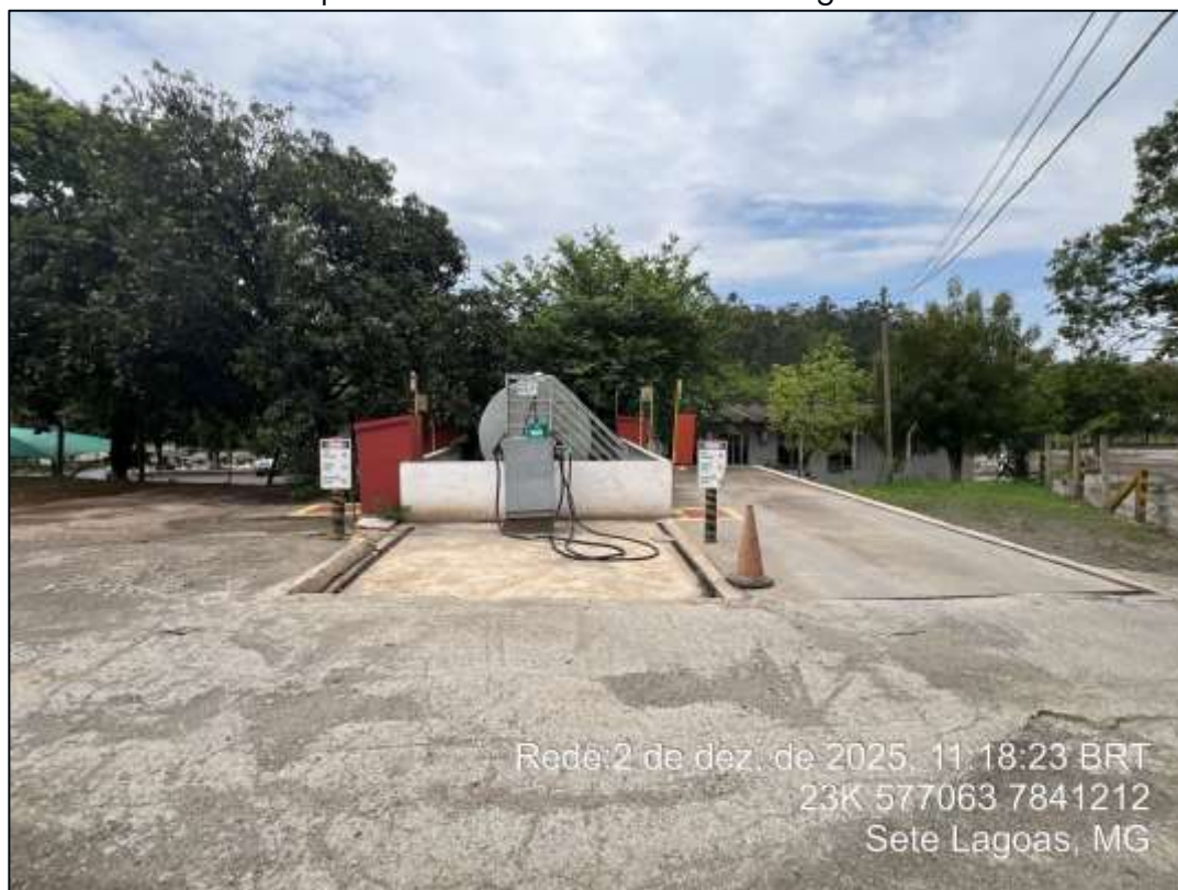
Foto 31: Tanque de combustível da Pró-Flora Agroflorestal Ltda.
