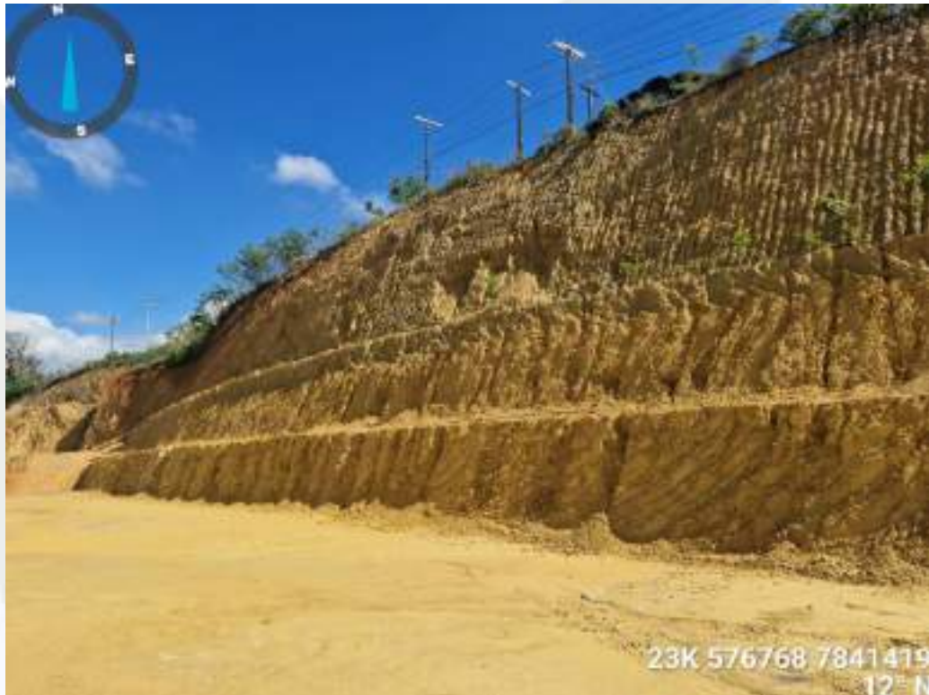
Figura 5 - Não existem grandes erosões nos taludes da cava.
