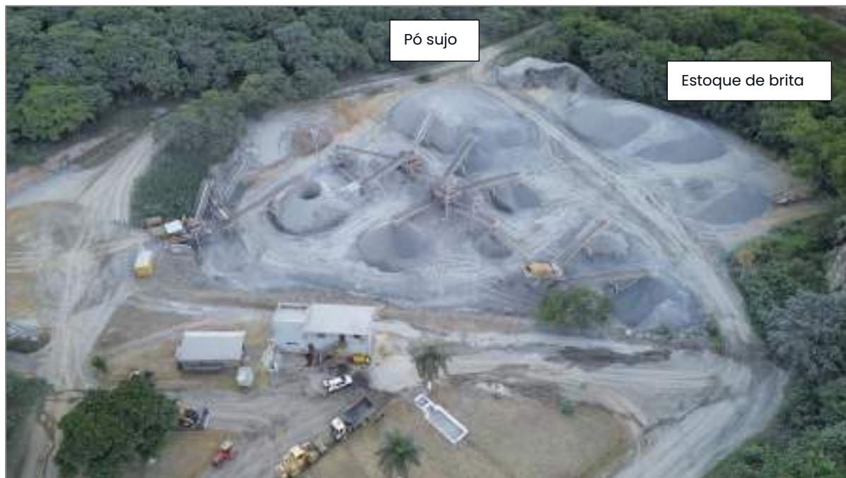
Foto 3: Vista da Unidade de Tratamento de Minério.
