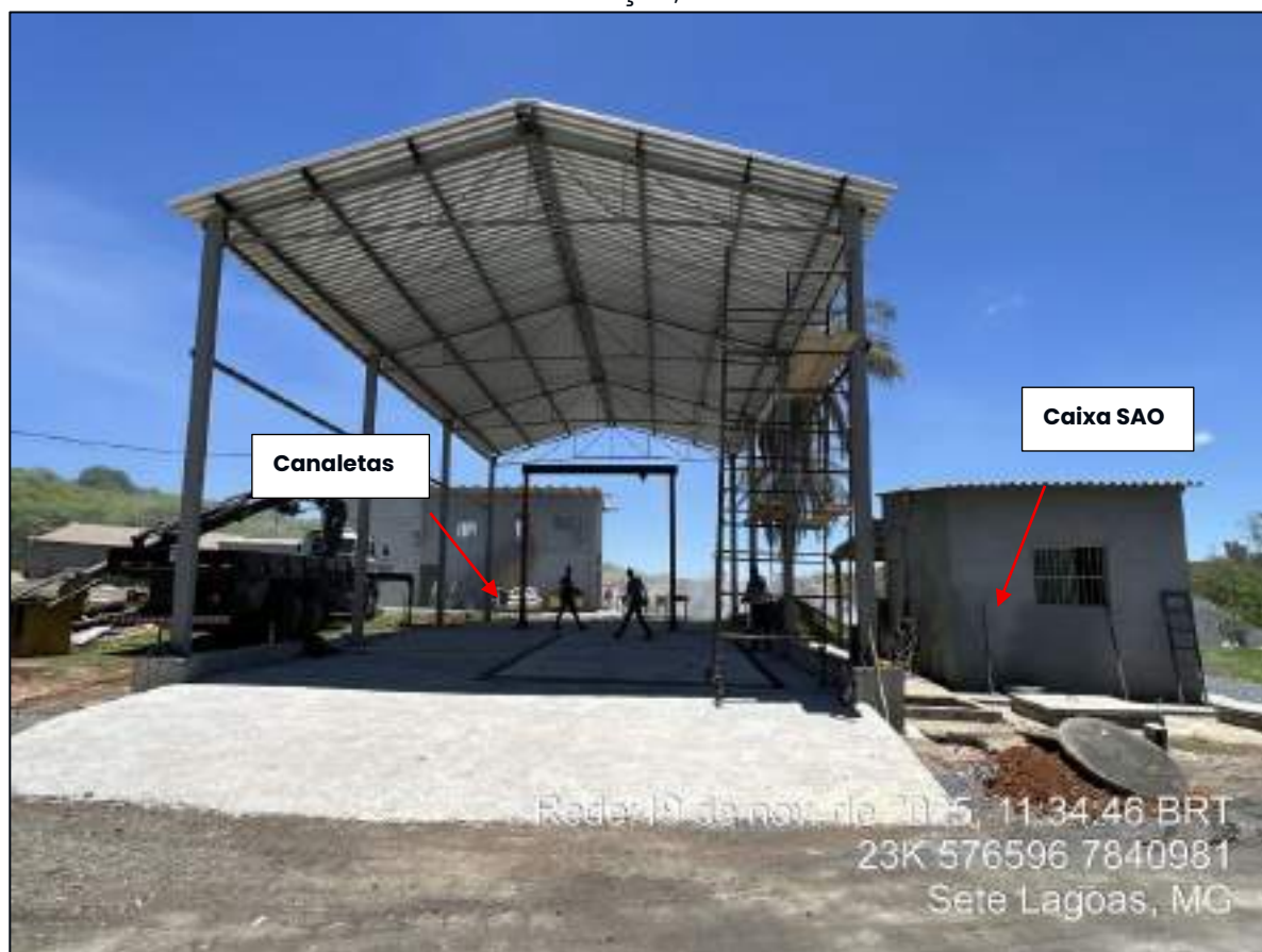
Foto 7: Área de manutenção, canaletas e caixa SAO.
