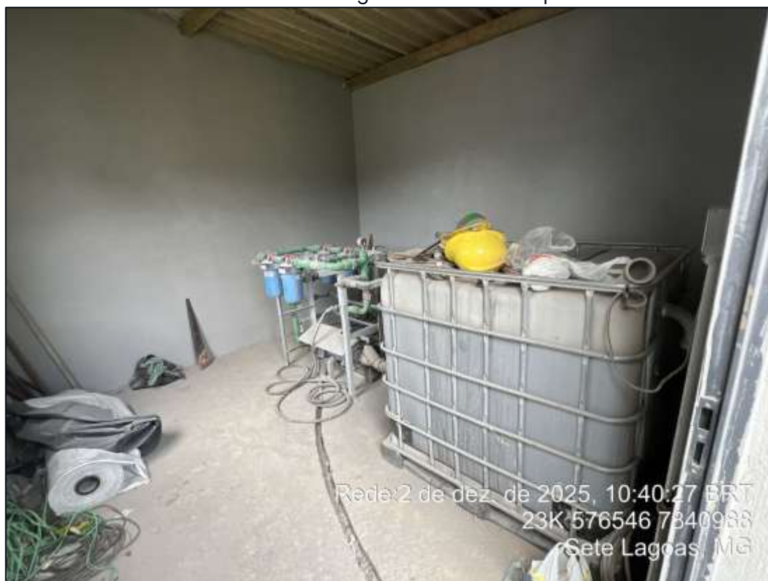
Foto 17: Armazenamento da água utilizada nos aspersores da UTM.
