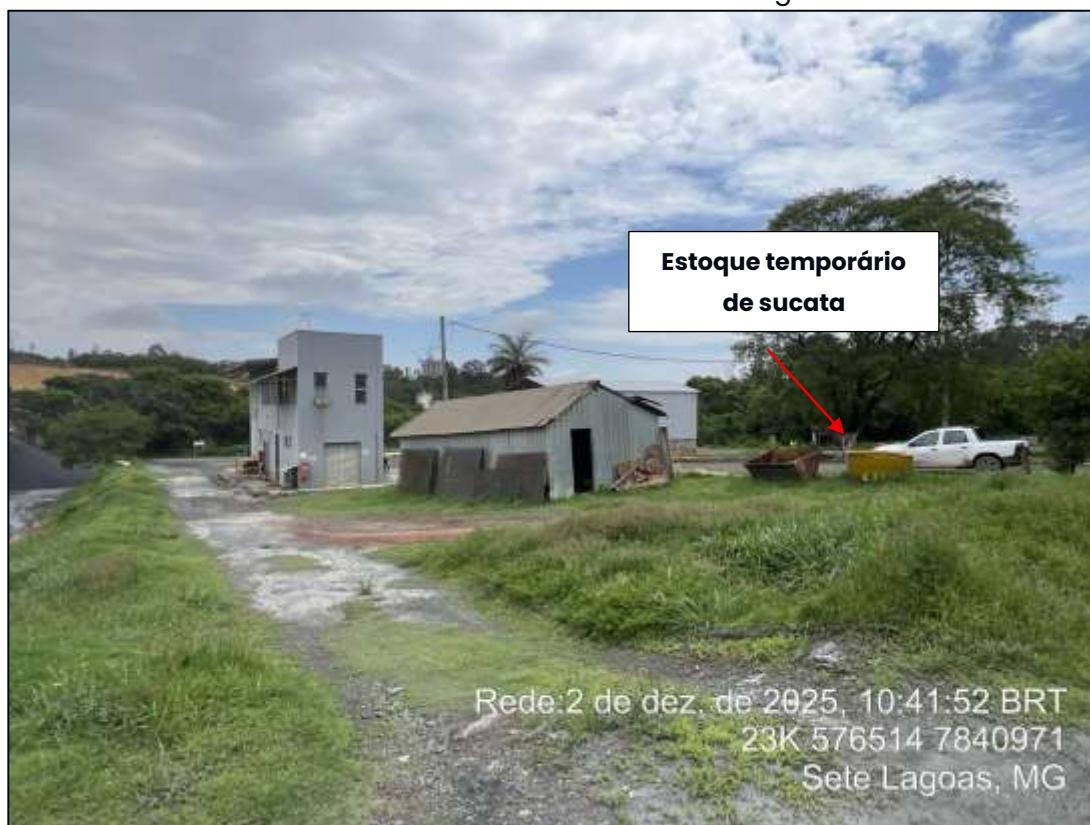
Foto 23: Vista externa da torre de controle e abrigo de resíduos.
