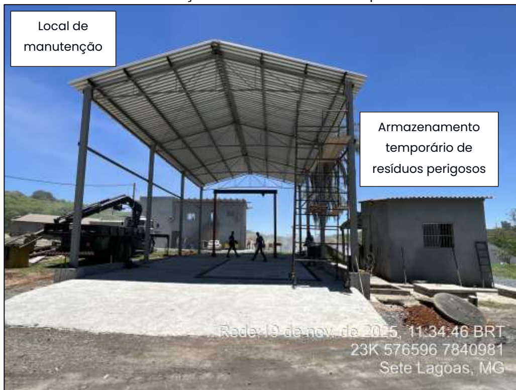
Foto 1: Área de manutenção e armazenamento temporário de resíduos.
