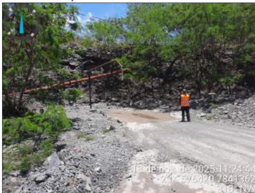
Foto 16: Tubulação e área de abastecimento de caminhões.
