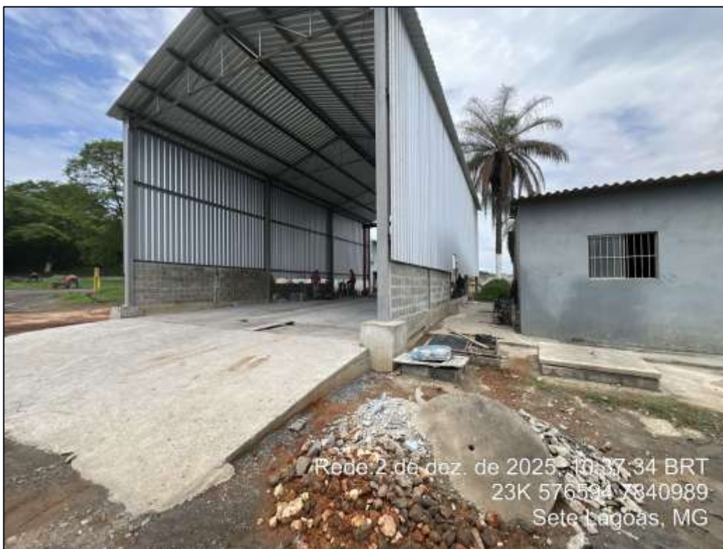
Foto 15: Área de manutenção, abrigo de resíduos perigosos e caixa separadora de água e óleo.
