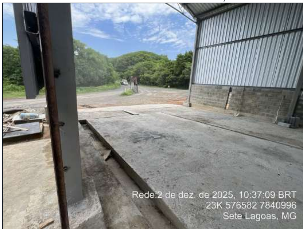
Foto 12: Canaletas da área de manutenção.
