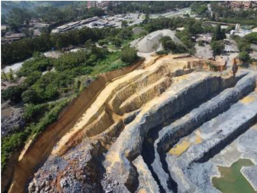
Figura 6 – Vista superior da cava do empreendimento.
