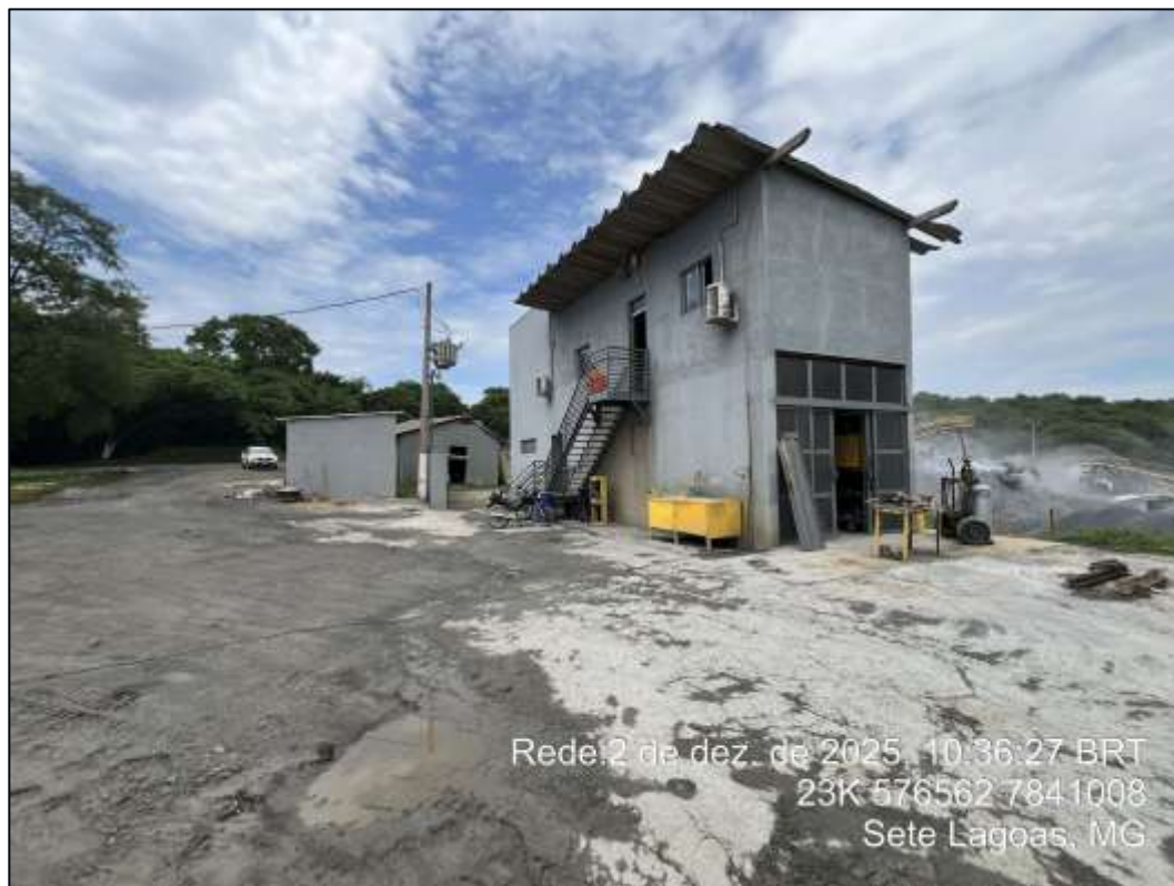
Foto 10: Torre de comando da UTM e refeitório.
