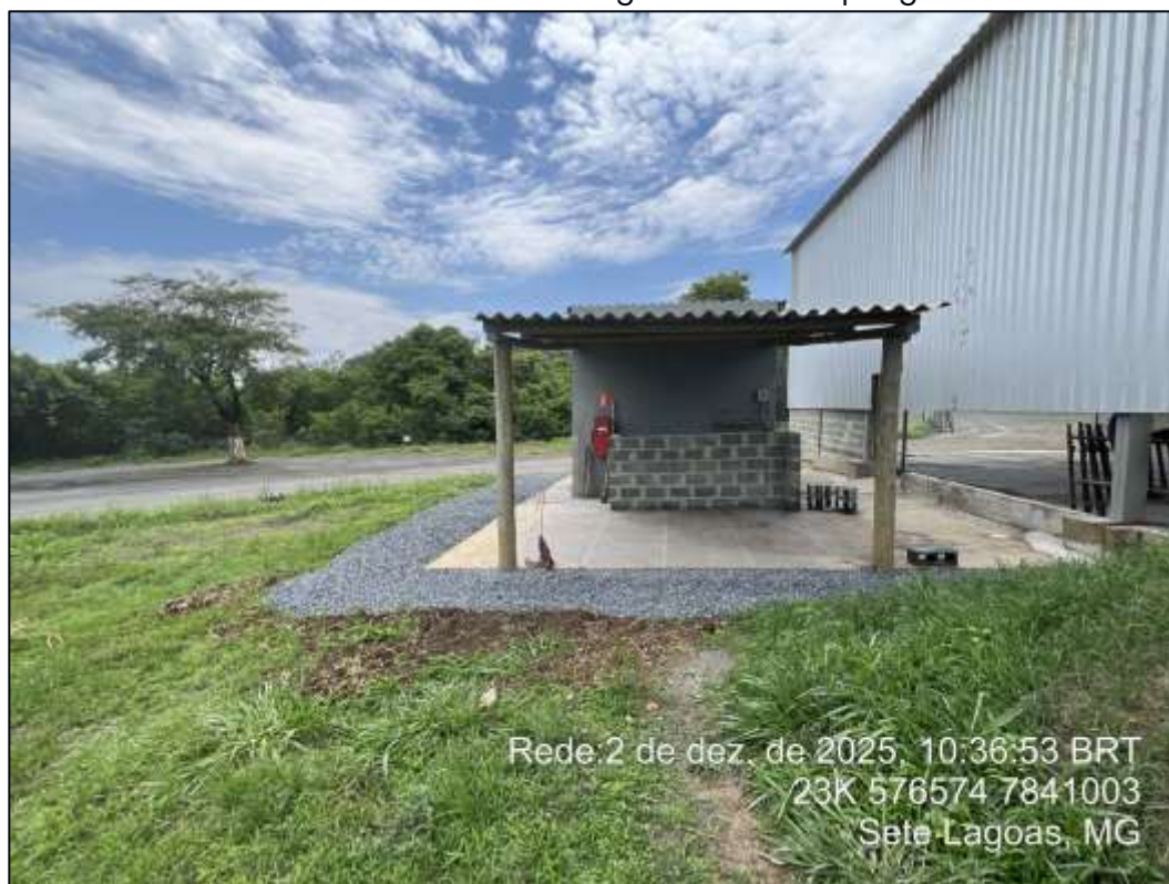
Foto 13: Vista externa do Abrigo de resíduos perigosos.
