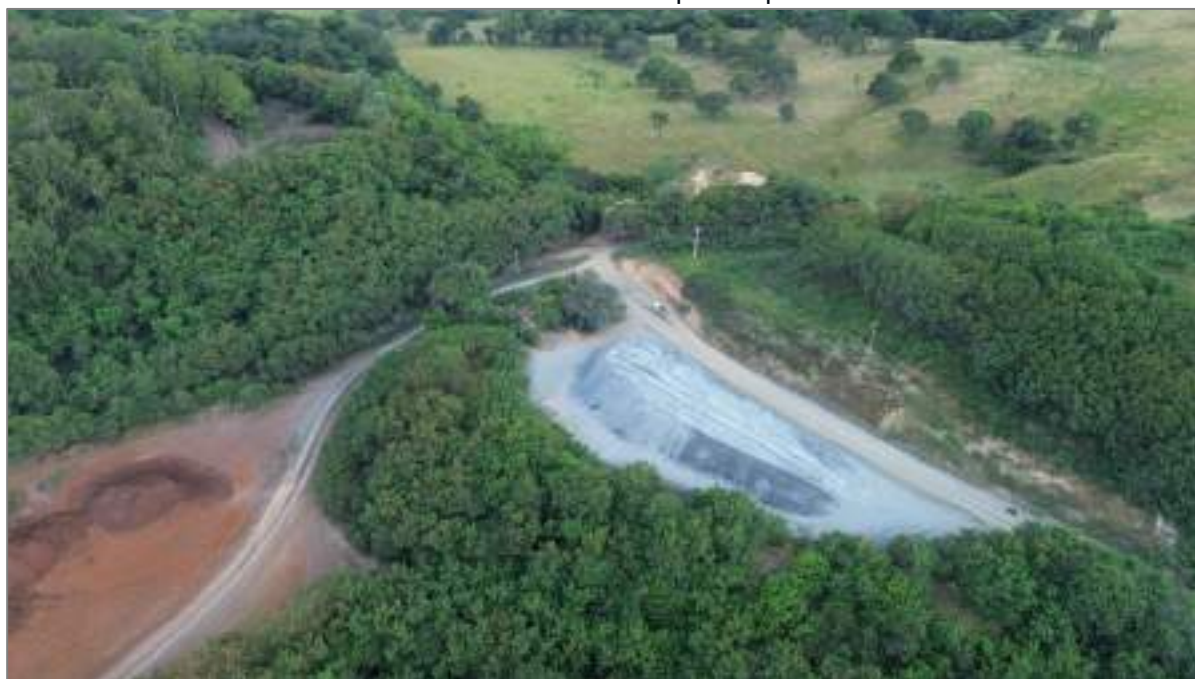
Foto 4: Vista da área de estoque do pó calcário.
