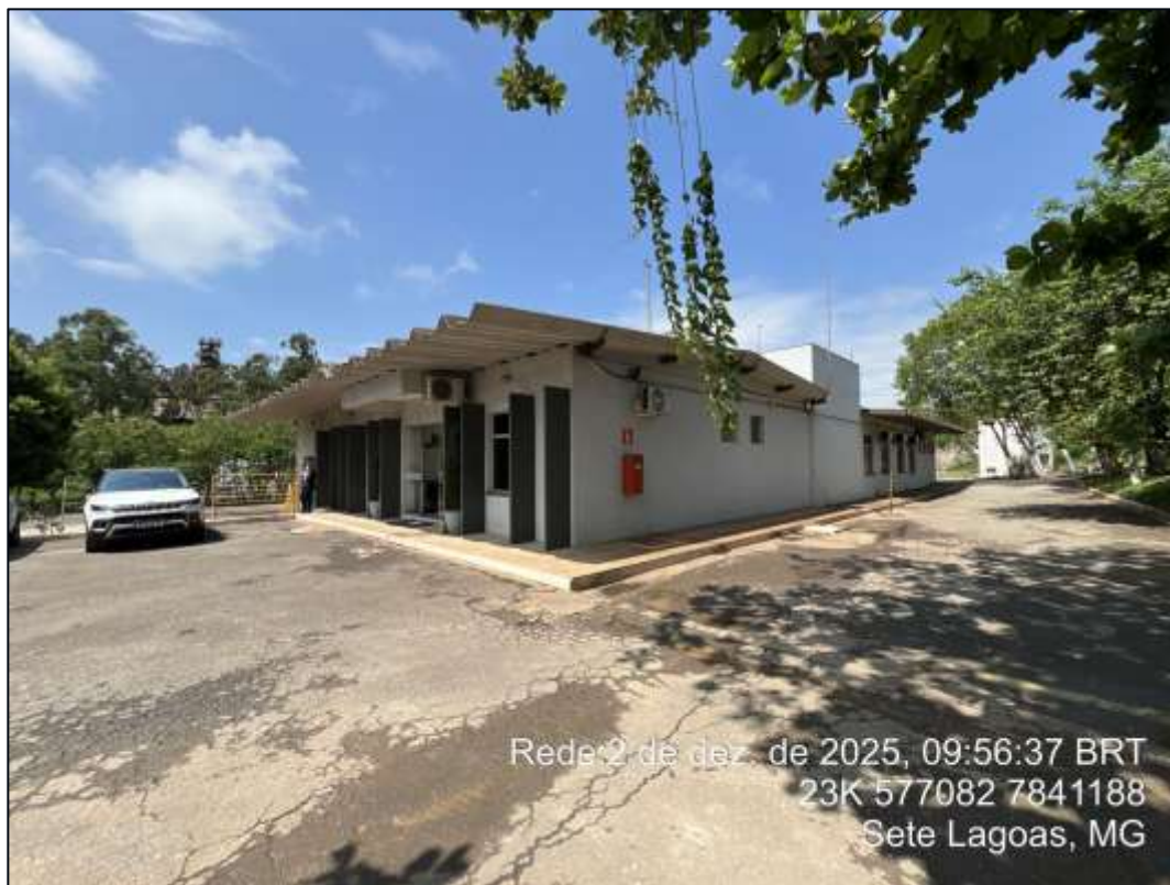
Foto 6: Escritório e Refeitório do Administrativo.
