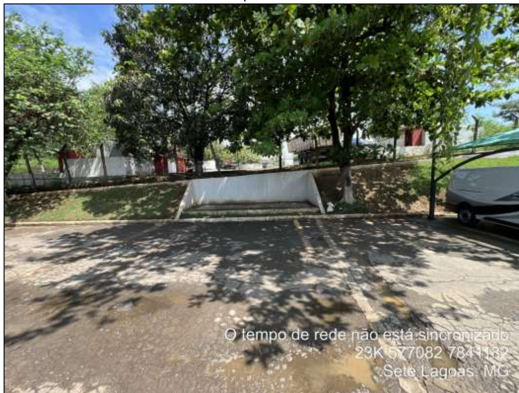
Foto 5: Fossa séptica – Administrativo.
