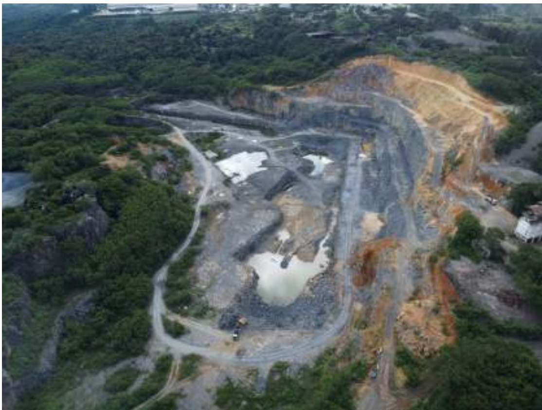
Figura 7 – Aspecto geral das bancadas da mina da Pro-flora.
