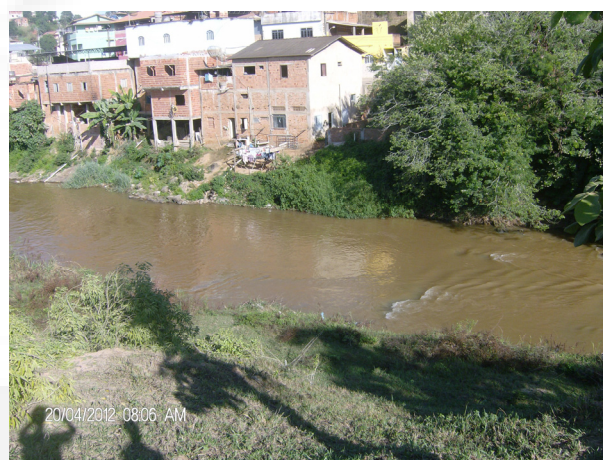
Foto 04. Trecho final de desvio do rio São Manoel e entroncamento ao curso original
