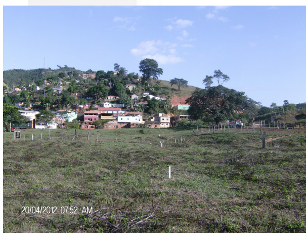
Foto 03. Local a ser implantado o canal para desvio do rio São Manoel após a confluência.
