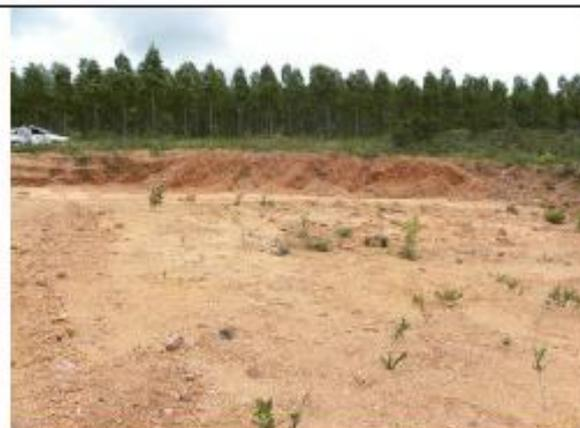
Foto Geo 18: Vista parcial de área de empréstimo posicionado fora do perímetro da Fazenda. Local onde é explorado material detrítico laterítico, utilizado na recuperação de vias.
